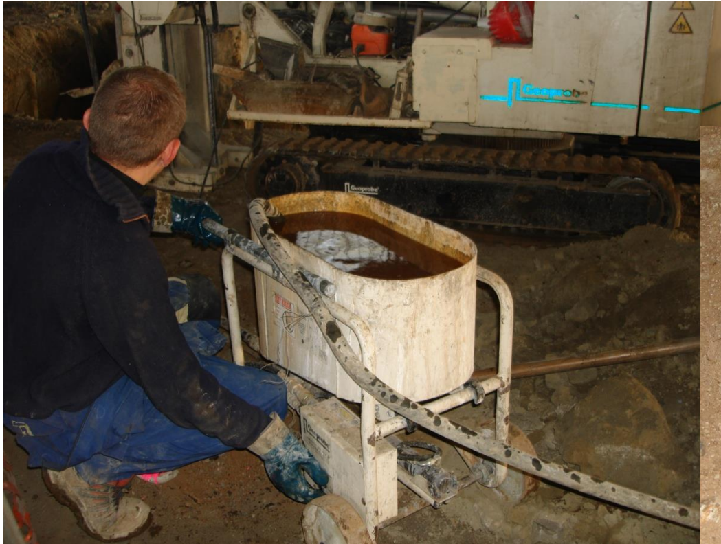
Pompa Geoprobe per iniezioni
